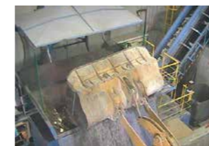
③破砕機投入口(限定公開)*
