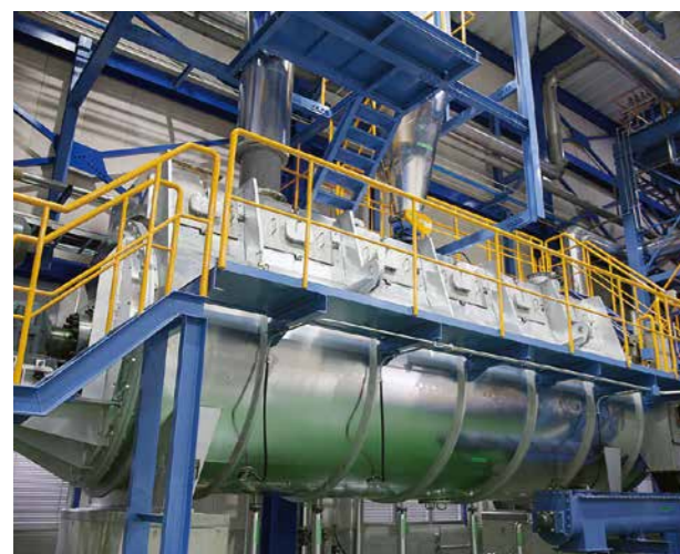
乾燥機 施設概要 処理方法：連続油温減圧乾燥方式(油炒め方式) 処理能力：90.9m 3 (約100t)/日(24時間稼働) 処理品目：汚泥、廃油、廃酸、廃アルカリ、動植物性残さ 環境対策：バイオマスボイラー、薬液洗浄装置
