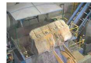
③破砕機投入口(限定公開)*
