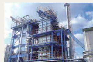
2014 バイオマスボイラー新設
