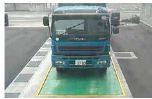
廃棄物の搬入・計量場所
